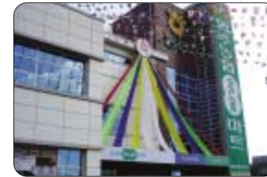
영주농협 파머스마켓 신축공사 준공
