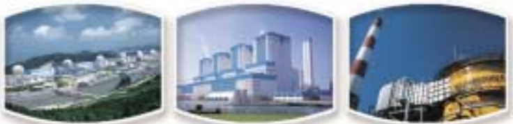
영광원자력발전소 단진화력발전소 탈황·탈질 설비
