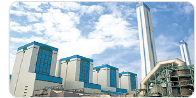
• 당진1~4호기 - 세계 최우수 Project 수상 <美 Power Engineering, 2001>
